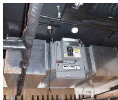
店内天吊設置
