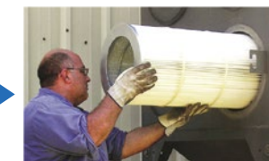
新しいフィルターを取付
